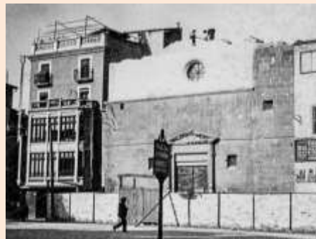
Derribo del convento de Santa Clara
