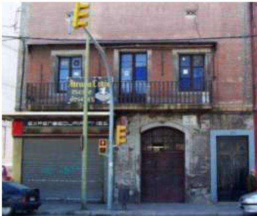
de Pueblo Nuevo en la calle Pedro IV.
