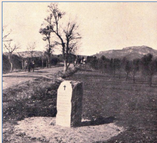
Carretera de Sabadell a Matadepera
